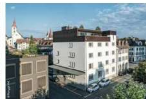
Surelévation avec création d'une terrasse.
